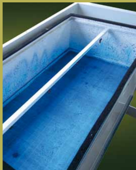
Filtro dopo il trattamento di incapsulamento
